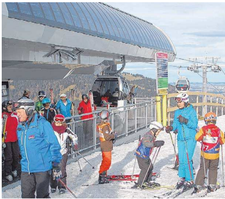
Die Bergstation der neuen Achter-Kabinenbahn bei Gunzesried. Sie ersetzt einen alten Sessellift. FOTO: UWE JAUSS
